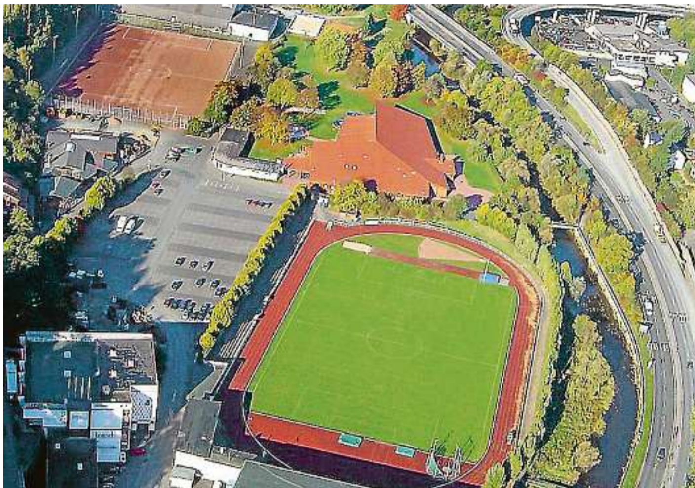
Neue Ideen für den Einkaufsstandort Dillenburg: Das Herborner Unternehmen Willi Lauber möchte am Stadion, im Bereich des Hartplatzes, ein Fachmarktzentrum errichten. Auf dem Maibachgelände in der Innenstadt soll ein Wohn- und geschäftskomplex entstehen. (Foto: Archiv)
