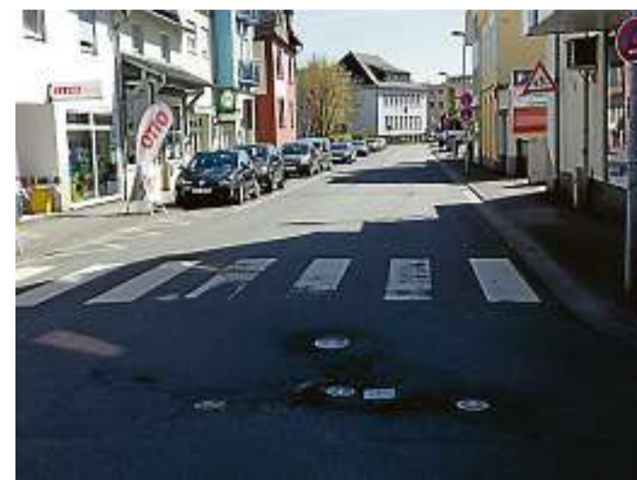
...und im Hintersand die maroden Fahrbahndecken im Laufe der nächsten Wochen sanieren. (Fotos: Stadt Herborn)
