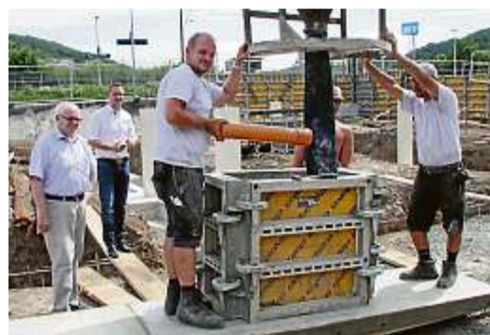
Grundsteinlegung: Beobachtet unter anderem von Bürgermeister Hans Benner (links), verfüllt Polier Steven Magnus (Mitte) mit Kollegen die Verschalung, in der die Zeitkapsel ruht, mit Beton.
